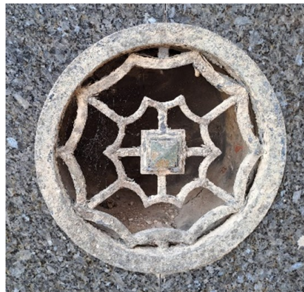
Verluchtingsgat in een gevel
